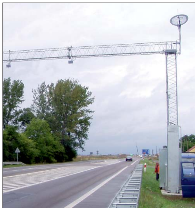
Fot. 7. Słup chroniony barierą energochłonną (źródło: Internet)
