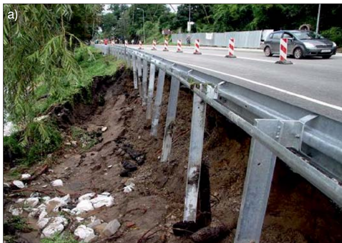
Fot. 6 a i b. Przykłady obsunięcia się skarpy przy drodze (źródło: Internet)
