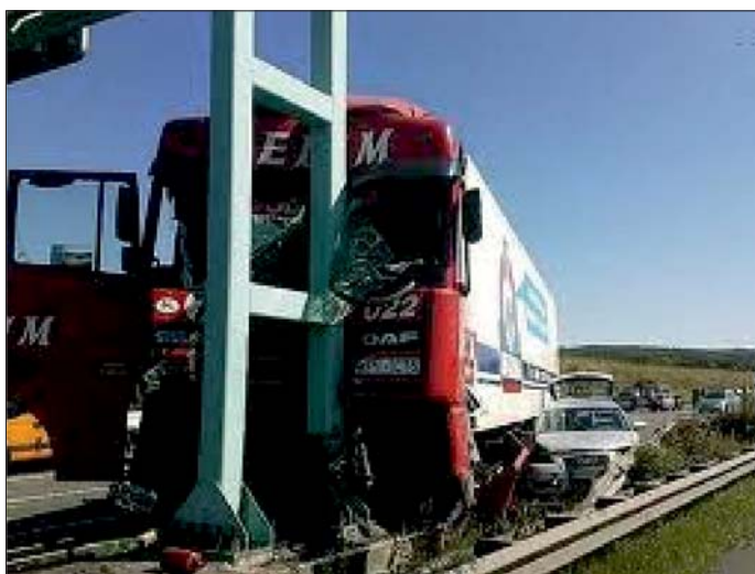
Fot. 10. Konstrukcja odporna na uderzenia (źródło: Internet)
