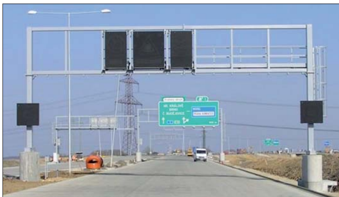
Fot. 9. Wysokie cokóły fundamentowe chroniące słupy (źródło: Internet)
