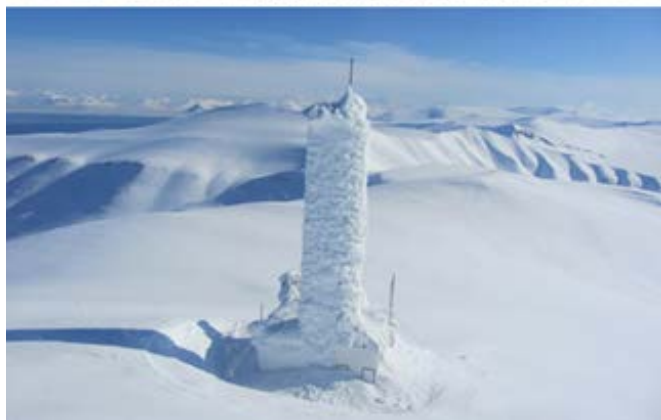
Rys. 9. Konstrukcja wieży RSB latem i zimą (fot. firma Brødrene Berntsen AS)
