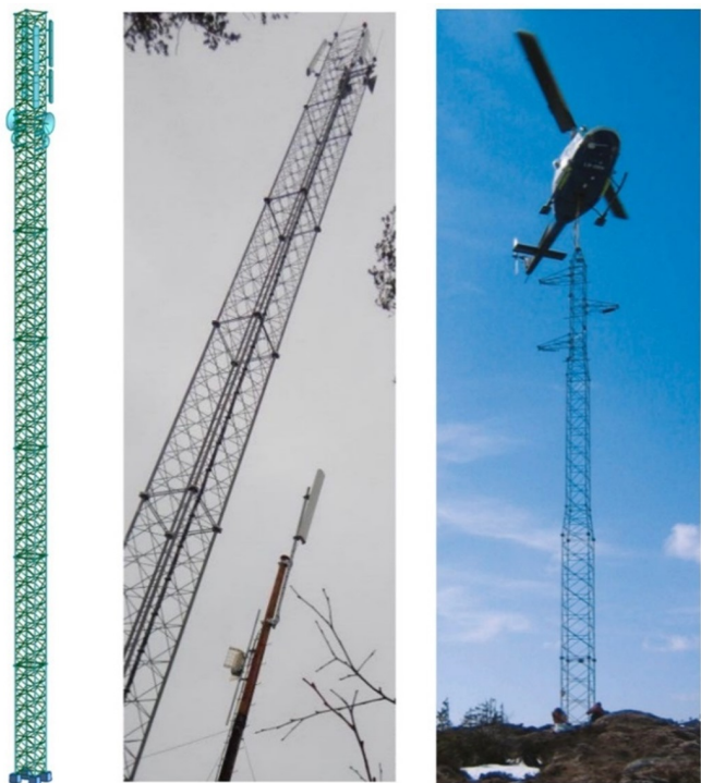
Rys. 8. Wieża telekomunikacyjna oraz słup energetyczny podczas montażu śmigłowcem (fot. firma Brødrene Berntsen AS)
