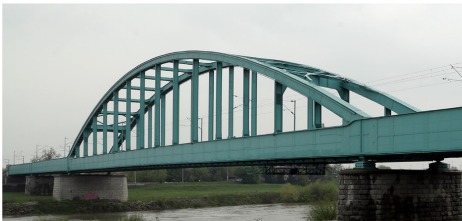
Rys. 3. Most kolejowy Hendrix Bridge na rzece Sava (1937) [7]
