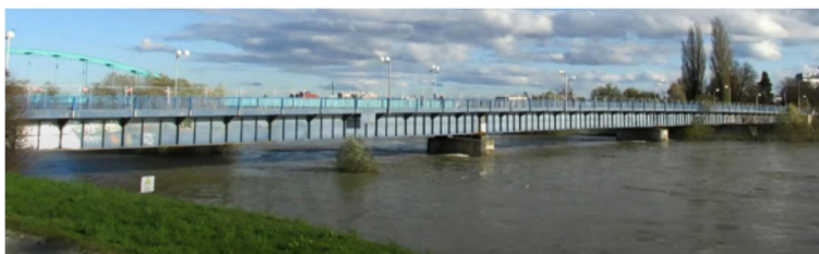
Rys. 1. Most drogowy na Sawie pod Zagrzebiem [7]
